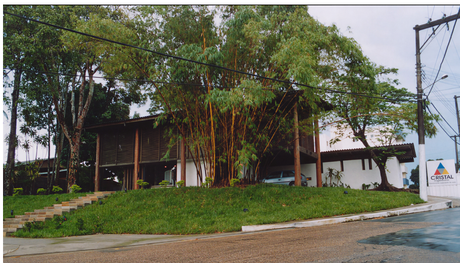
Fonte: Acervo Pesquisa Casas Brasileiras. Figura 4. Vista Fachada Residência Recife.
